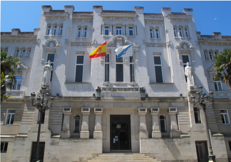
Fachada principal del Palacio de Justicia, sede del TSXG.
